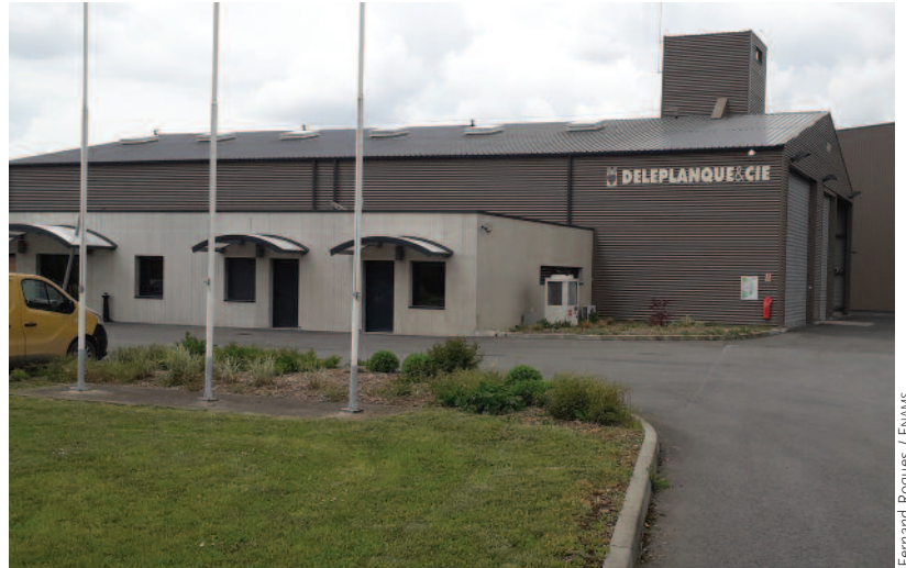
La station de Villefollet (Deux-Sèvres) permet d'assurer sur place les étapes de réception, triage, traitement, conditionnement, certification et dispose depuis 2018 d'un laboratoire d'analyses.
